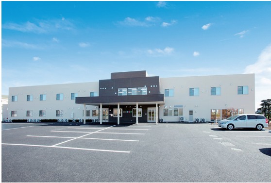
※施工例(某福祉施設)
