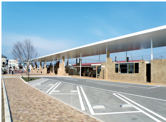
施工例：上州富岡駅舎
